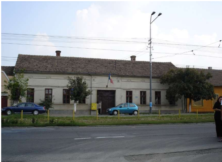
Ehemaliges Schulgebäude – Calea Timisorii nr. 77
