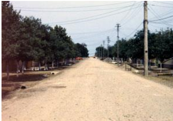
Ehemalige Straßenansicht aus Baumgarten
