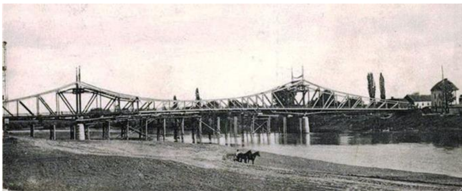
Podul grof Károly (Traian) în construcție.
