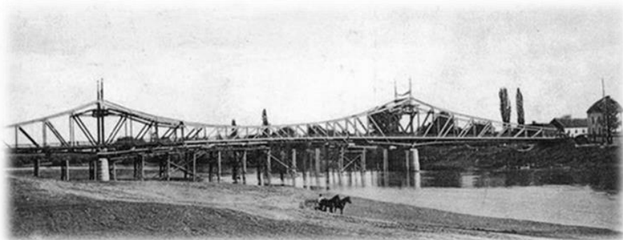
Brücke gróf Károly im Bau, 1909
