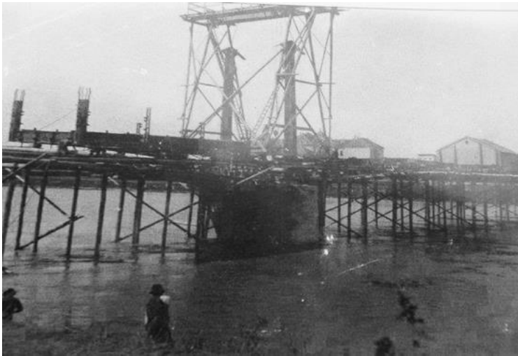
Bau der Pfeiler der Elisabethbrücke
