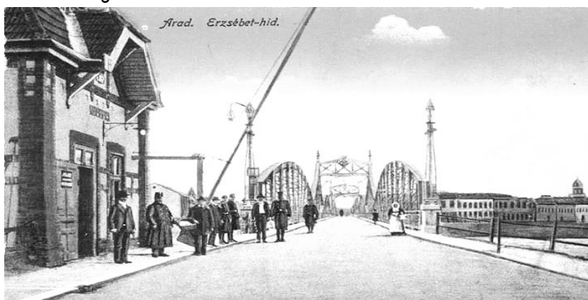
Elisabethbrücke und deren Zollhaus
