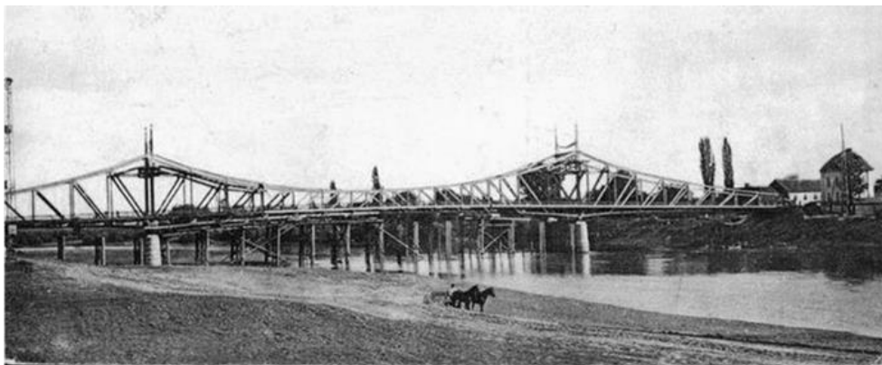
Brücke Grof Károly (seit 1919 Trajansbrücke) im Bau
