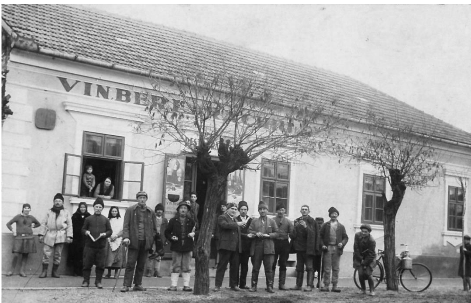
Restaurant von Novak. Dahinter befanden sich die Garagen der Autobusse.
